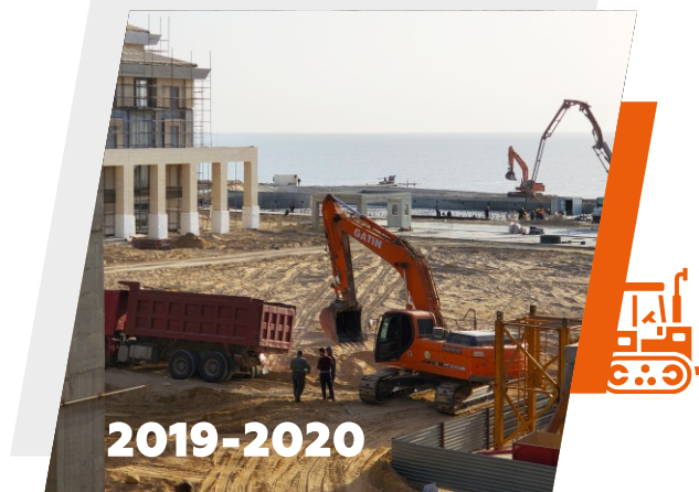
Выполнение земляных работ при строительстве Rixos Water World Aktau
