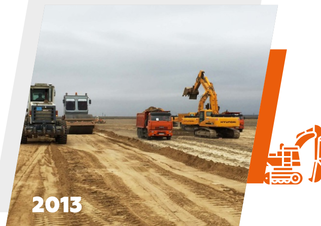
Возведение земляного полотна при строительстве ЖД линии Бейнеу-Шалкар
