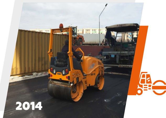
Выполнение дорожно-строительных работ при строительстве здания КАЗМОРТРАНСФЛОТ 14 мкр г. Актау
