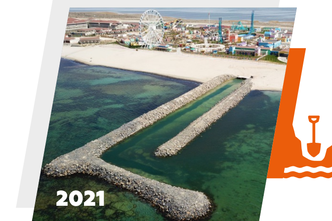
Строительство мола и водозапорного канала, а также асфальтирование территории Tetys Blu Theme Park
