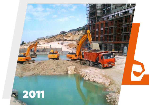
Разработка котлована под строительство отеля Caspian Riviera
