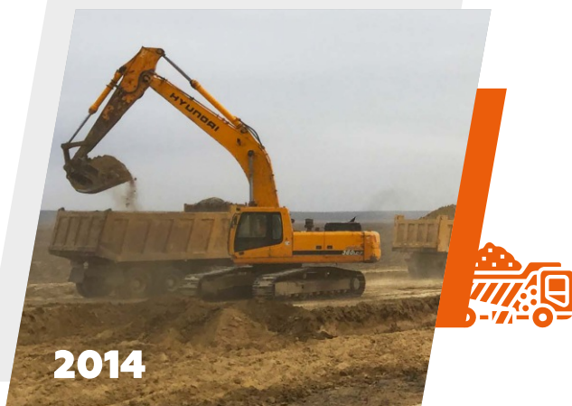
Возведение земляного полотна при строительстве ЖД линии Боржакты-Ерсай
